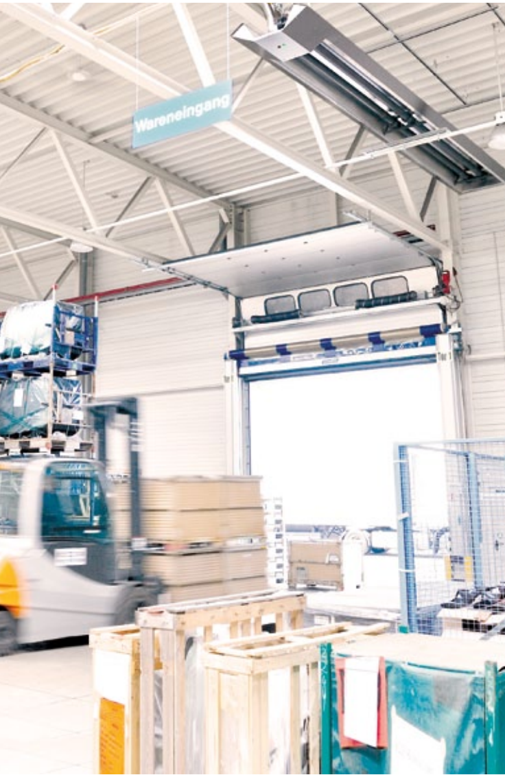
Gasbetriebener Infrarot-Dunkelstrahler
