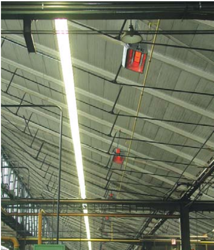
Bild 3: Typische Anordnung von Hellstrahlern unter einem Sheddach
