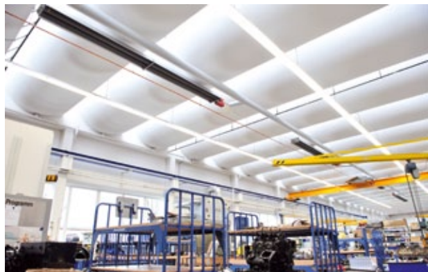
Abgasführung von Dunkelstrahlern über ein Sammelabgassystem
