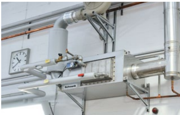
Das Herzstück einer hybridSchwanck Anlage: der Schwanck Luft-Wasser Wärmetauscher
