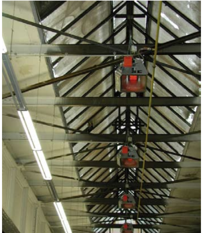
Bild 1: Einsatz von energiesparenden und vollisolierten Gas-Infrarot-Hellstrahlern Typ supraSchwank bei der Hyco Pacoma GmbH
